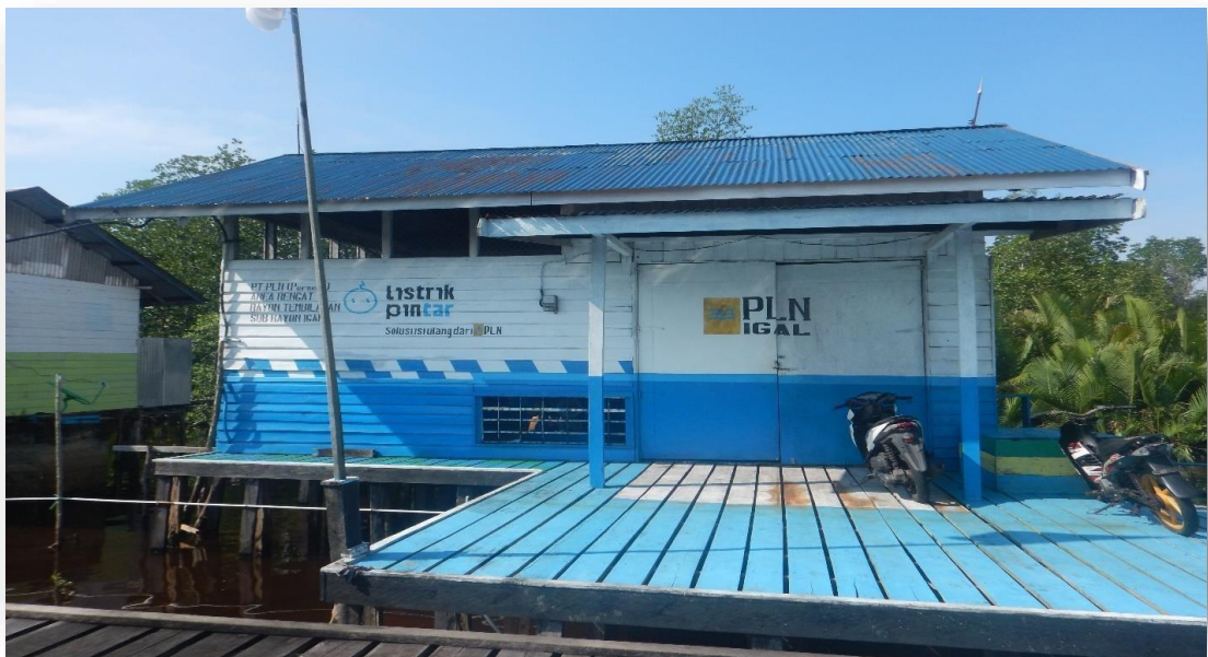
Gambar Bangunan PLN Desa Igal
