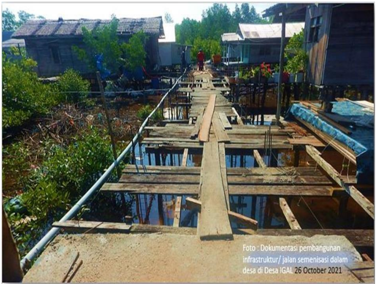
Gambar Infrastruktur Pembagunan Jalan
